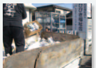
トラックへ積み込み!
